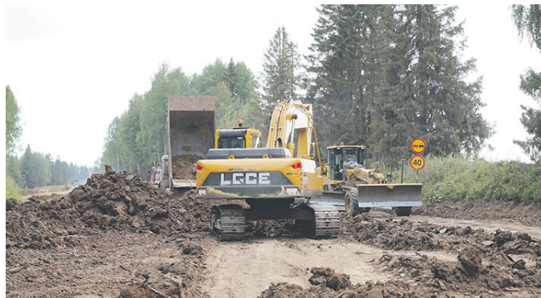
Техника максимально задействована для подготовки поверхности дороги для её реконструкции.
