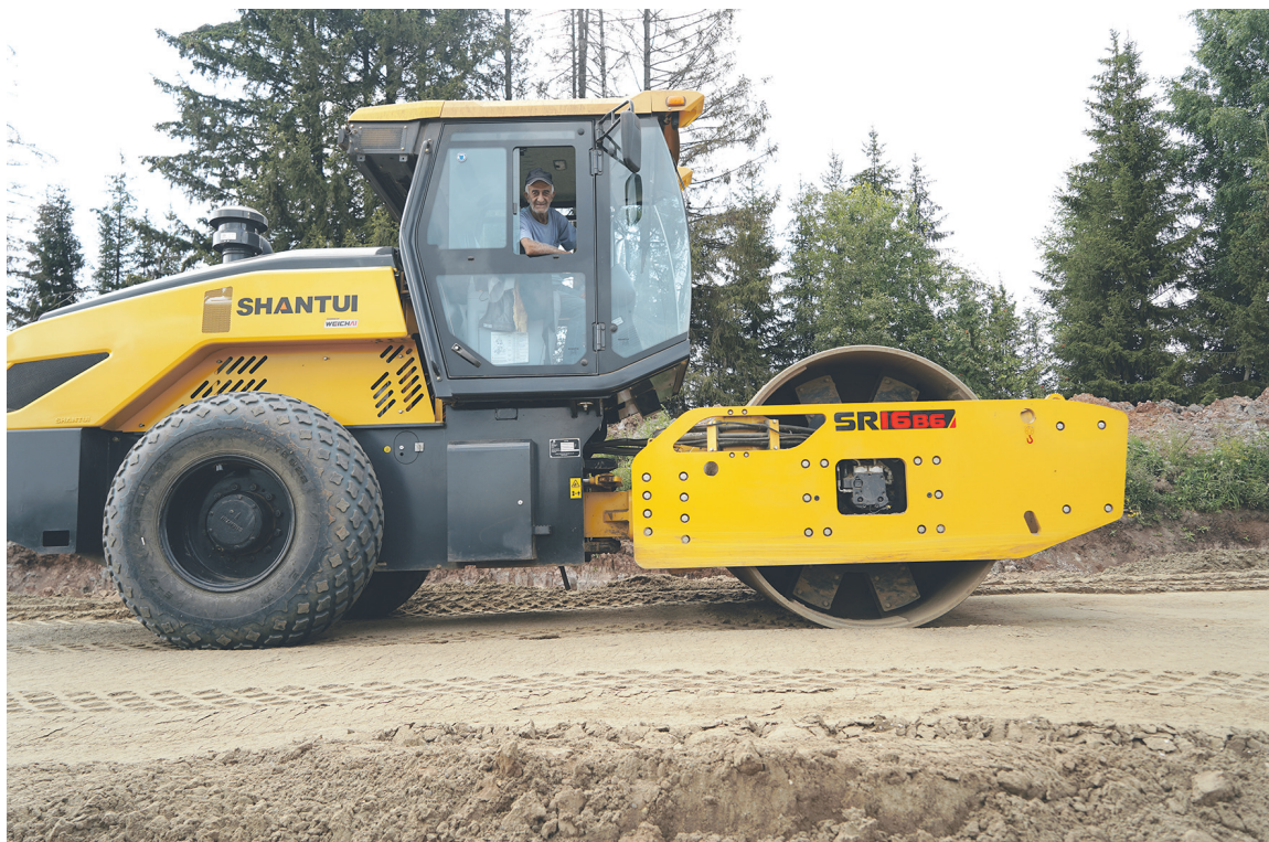
Механизатор Сос Варданян на дорожном катке уплотняет грунт./Фото Ирины Перевозчиковой
