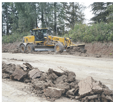
Грейдер выравнивает поверхность, снимает верхний слой старого грунта.
