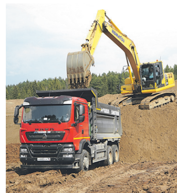
Экскаватор загружает в самосвал ПГС.
