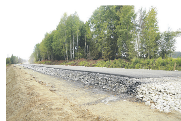
Участок дороги с новым асфальтом.
