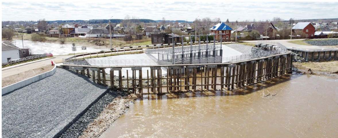
Ремонт ГТС на реке Кува.
