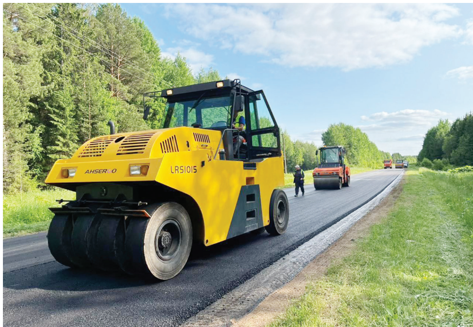
Ремонт участка дороги «Кудымкар – Ошиб».
