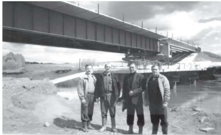
Строительство моста через реку Обва.
