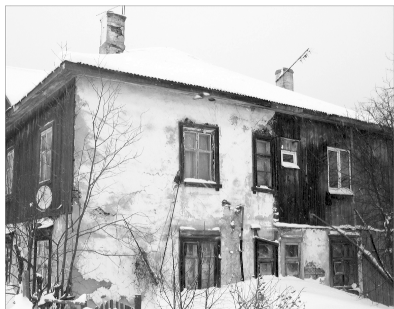
Дом №3 по ул. Шахтерской в посёлке Сараны
