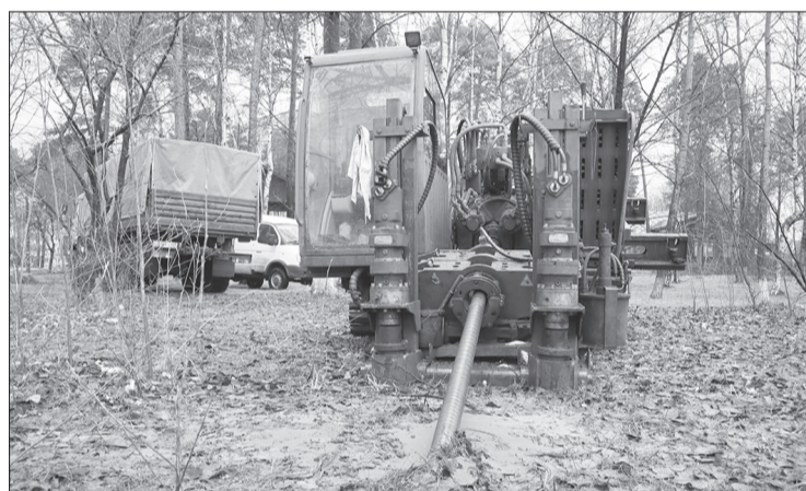
На первом этапе работ новую трубу проложат под дорогой на улице Шоссейной методом горизонтально-наклонного бурения. Машина уже завезена, ожидается поставка траншейных крепей. Фото Дмитрия Зеленкина
