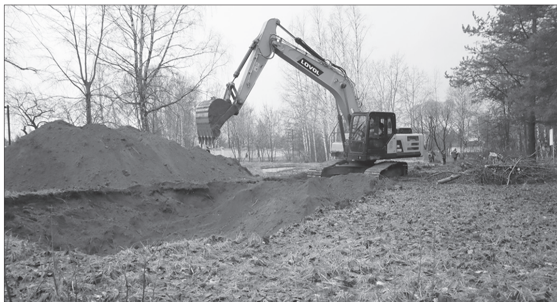
Реконструкцию канализационного коллектора на улице Шоссейной, в том числе в парке Победы, проводит компания «Инженерные системы». Сейчас рабочие ведут подготовительные работы: вырубая деревья и другие насаждения на всем участке. А также копают широкую траншею для предстоящих раскопок на глубину 6-8 метров. Фото Дмитрия Зеленкина
