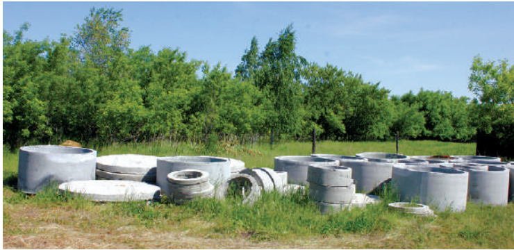
На учхозе начались работы по реконструкции центрального водопровода
