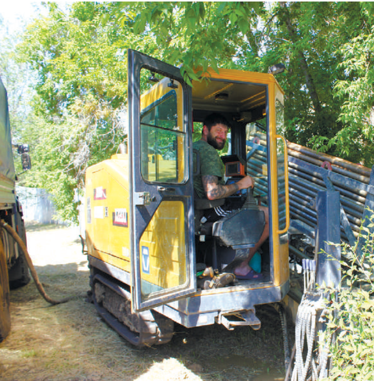
Работы ведутся методом горизонтального бурения.
