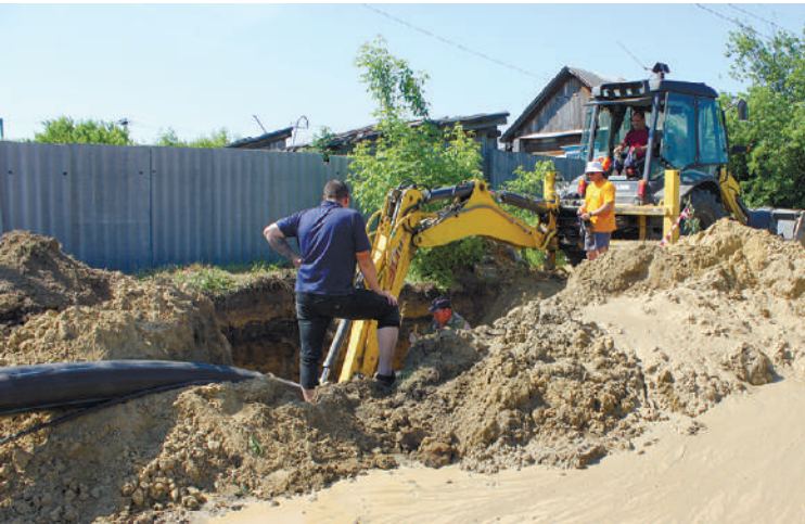
Ведутся работы на улице Томина, где старый водопровод доставлял немало проблем коммунащикам и потребителям.
