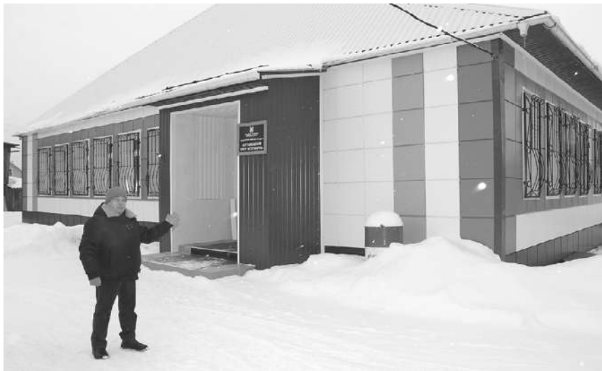
Современным стало здание Куртамышского центра ветеринарии, где недавно завершился капитальный ремонт.. / ВСЕ ФОТО НАТАЛЬИ ВАЛЯЛКИНОЙ.
