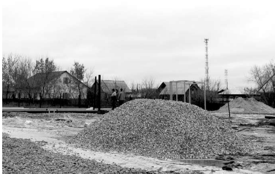
На Учхозе обустроены и огорожены две площадки, на которых будут установлены новая насосная станция, станция водоподготовки.
