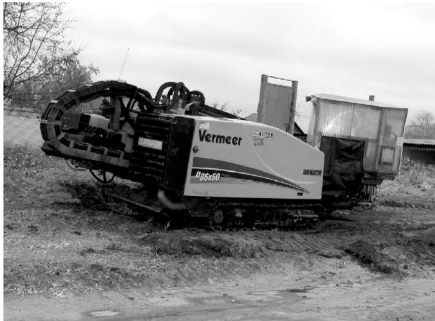
Вот такой специализированной техникой выполняется строительство водопровода методом горизонтального бурения.
