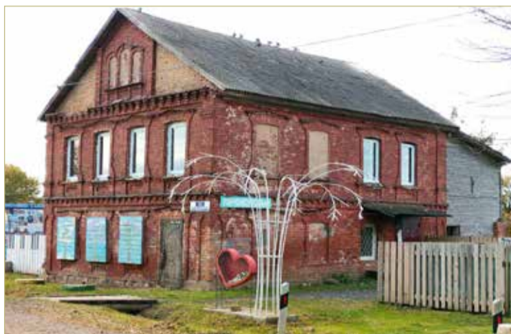
Благодаря конкурсу ППМИ тосовцы полностью отремонтируют старинное здание.
