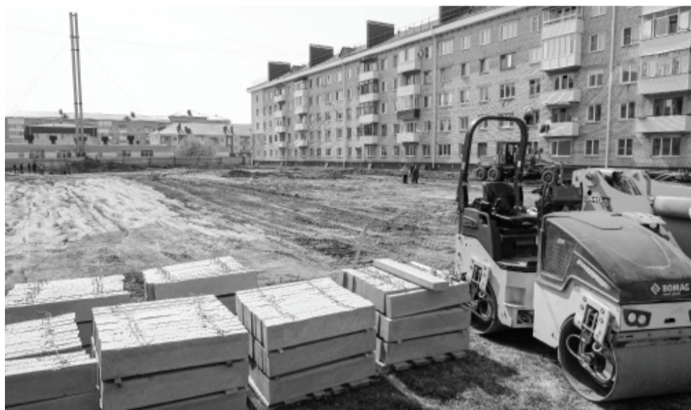
Строители подготовили площадку под благоустройство, впереди еще много работы. // Фото Василия БАРАНОВА.
