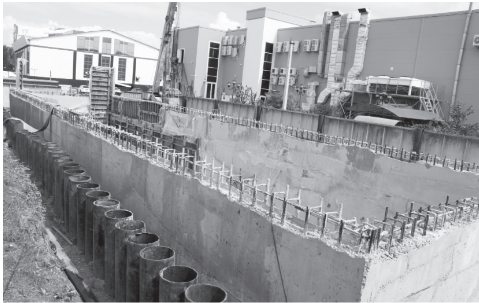
Первый из трех резервуаров чистой воды готов на 70 процентов — залиты бетонное основание и стены. // Фото автора.
