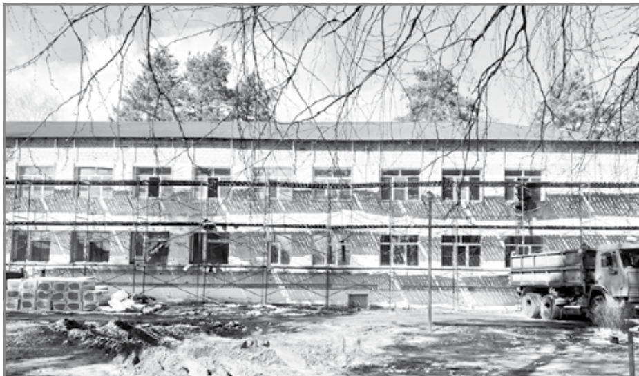
Ремонт фасада здания
