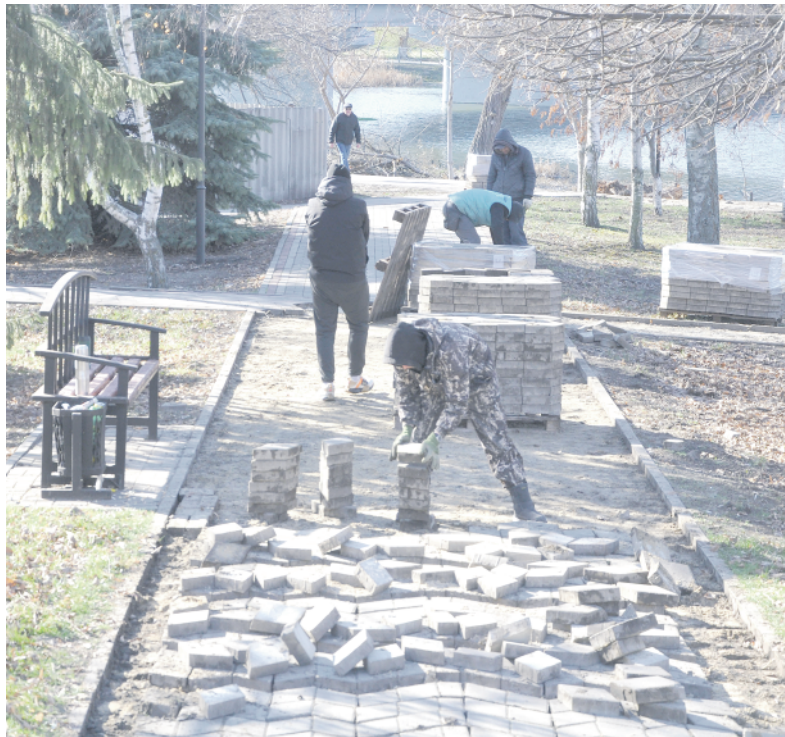
С утра до вечера на набережной ведутся работы по демонтажу тротуарной плитки.
