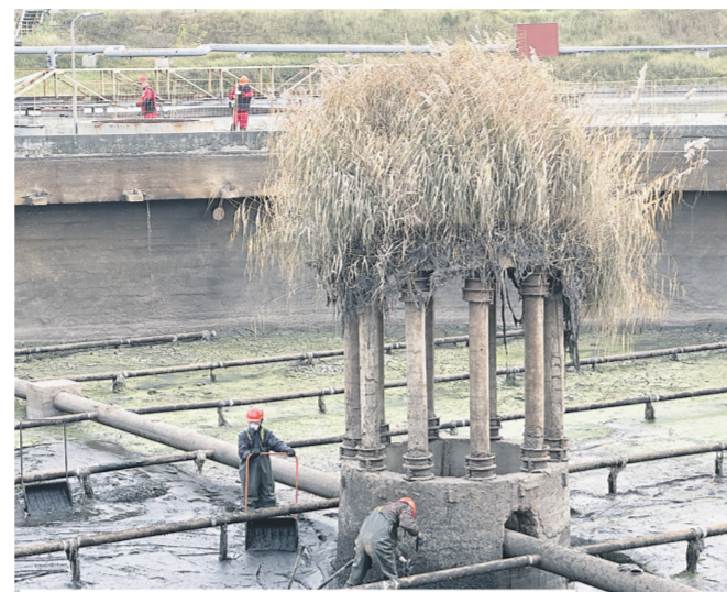
1-й, 2-й и 3-й этапы реконструкции идут одновременно. Подрядчики укрепят чаши аэротенков и заменят систему аэрации в них
