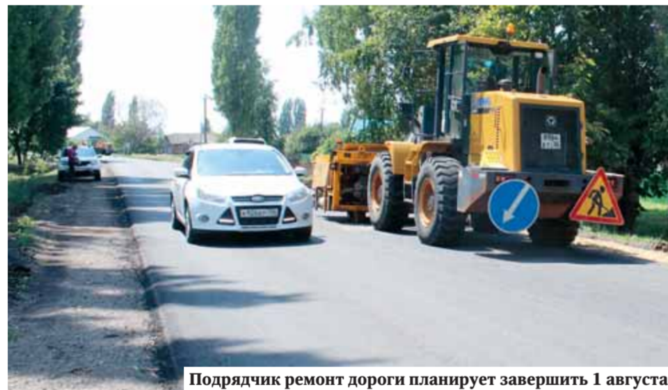
Подрядчик ремонт дороги планирует завершить 1 августа
