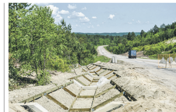
Дорожники используют монолитные лотки для водоотведения вдоль трассы.
