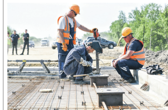
Двухпролетный мост, построенный взамен аварийного, будет находиться под охраной.
