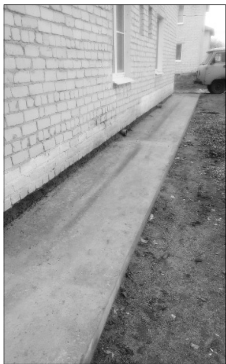
Новая отмостка у дома по ул. Советской, 62.
