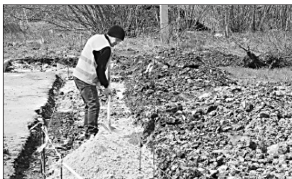
Укладка песка – необходимый процесс при строительстве пешеходной зоны. / ФОТО: Н. ГЕННАДЬЕВА
