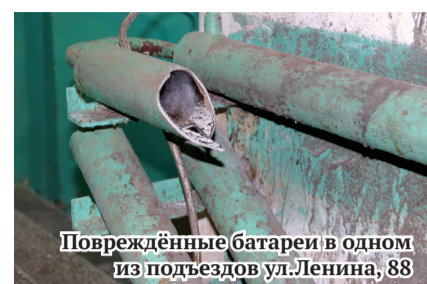
Лёд в системе отопления – причина лопнувших батарей.
