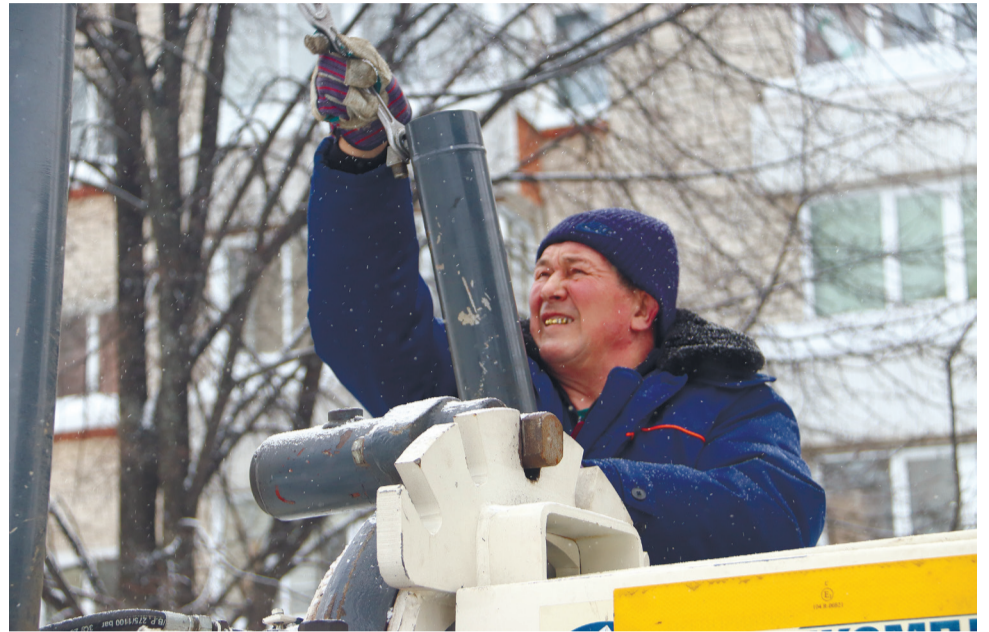
Починка грейдера без отрыва от процесса уборки снега.
