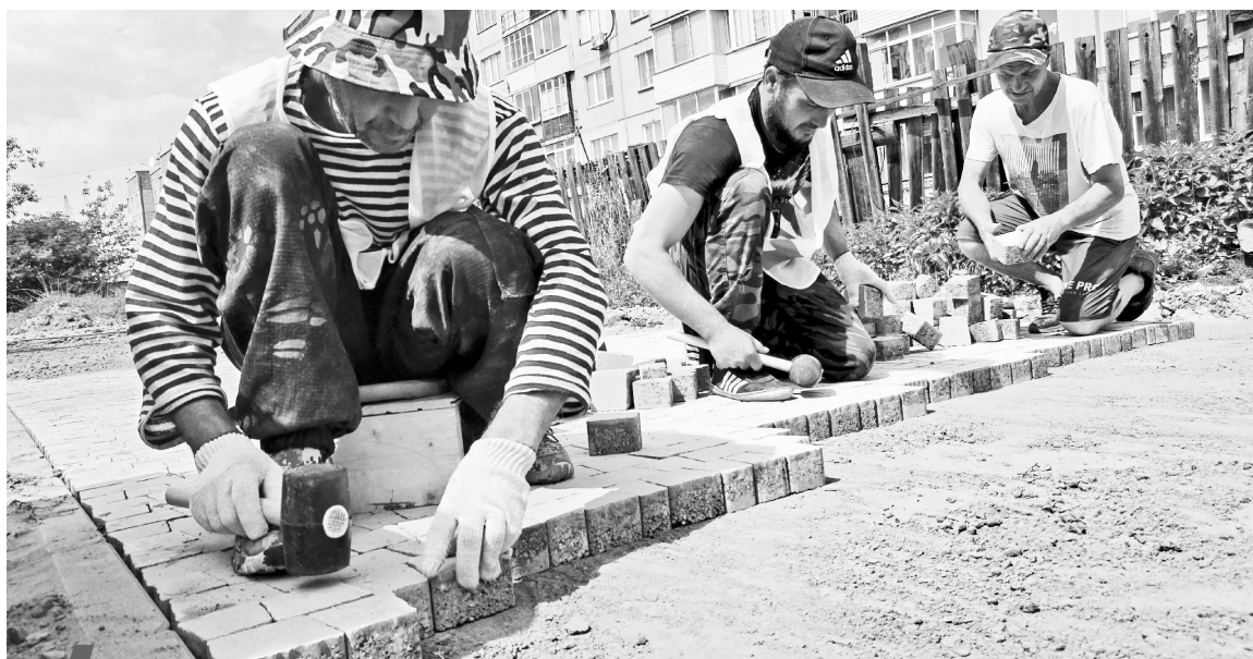
В районе ДРСУ ведутся работы по созданию нового общественного пространства. А по соседству совсем скоро начнётся благоустройство дворовой территории и строительство спортивной площадки
