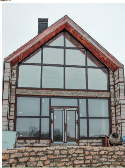
Семья Санкиных завершает строительство оригинального дома.
