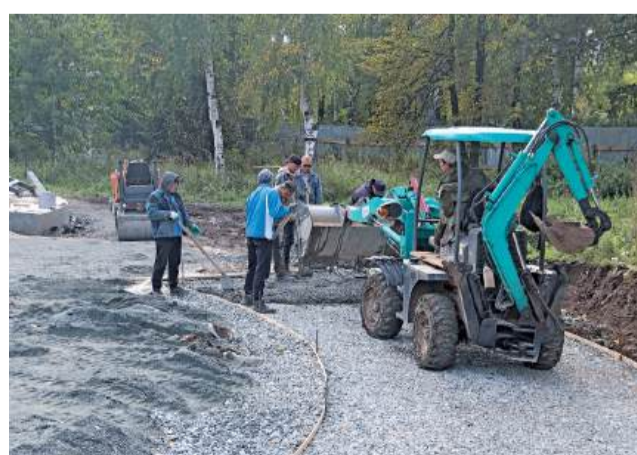
Бетонирование основания будущего зрительного амфитеатра.
