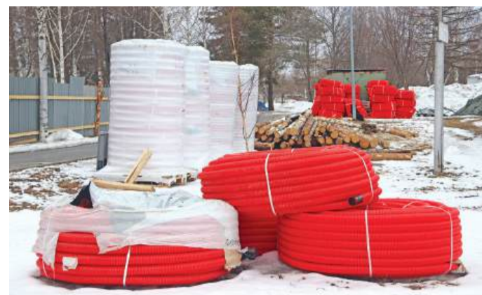
Специальные гофрированные трубы для прокладки электрокабеля ждут начала земляных работ.
