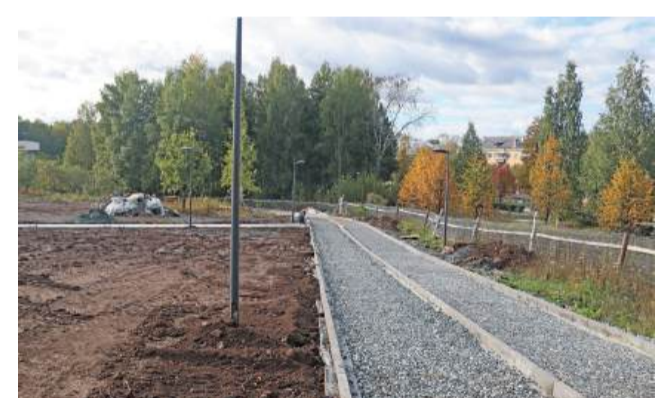
Подготовка к асфальтированию новой лыжероллерной трассы.
