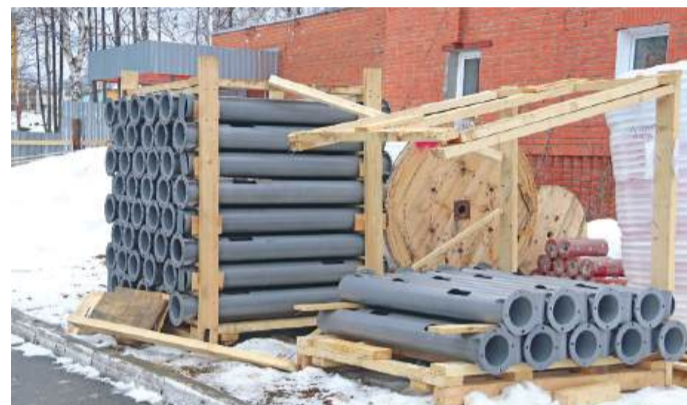
Скорее начнётся установка закладных фундаментов для опор освещения.
