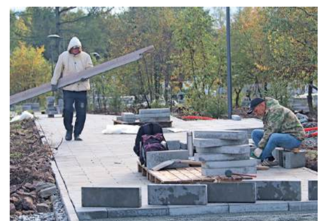
Работы по обустройству парковых тротуаров.
