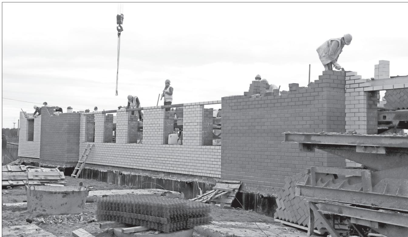
Пока плотники заливают опорный пояс между вторым и третьим этажами первого подъезда, каменщики выполняют кирпичную кладку второго этажа второго и третьего подъездов. В день нашего визита здесь работало около 20 человек. Все они рано утром приезжают на служебном транспорте из Талицы. Срок сдачи объекта – лето 2024 года.
