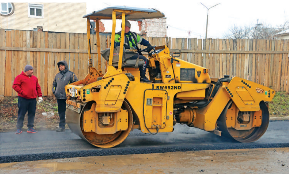
Завершение работ по асфальтированию заезда во двор 62 квартала.
