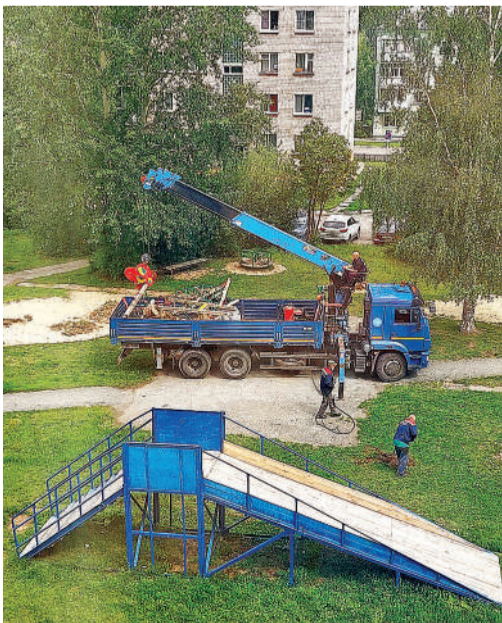
Демонтаж старого игрового оборудования.
