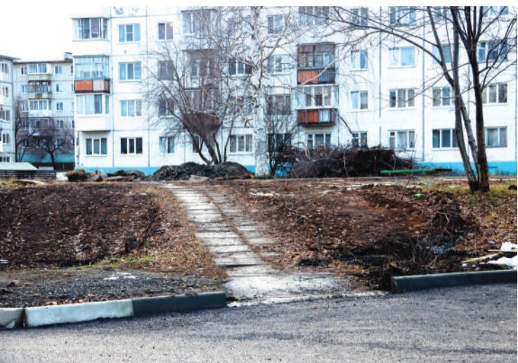
Обустройство новых тротуаров запланировано на 2024 год.
