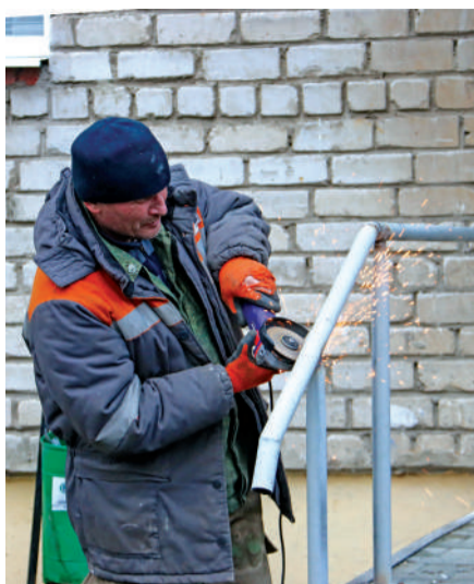
Обустройство перил у подъездов домов.
