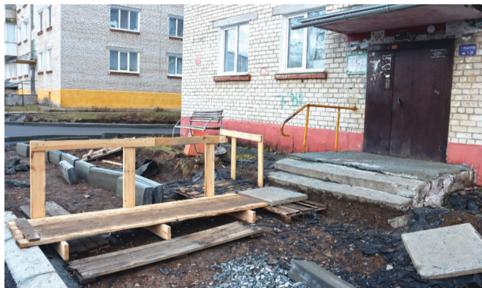
Временные настилы к подъездам Кирова, 32.
