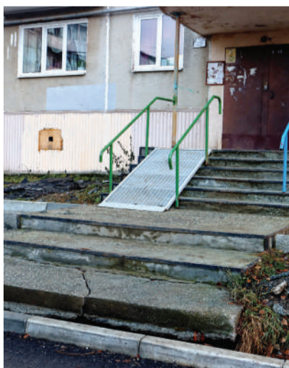
Ремонт крылец обязательно состоится.
