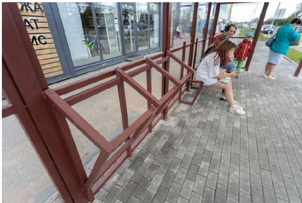
КАРКАС ОСТАНОВКИ УЖЕ СМОНТИРОВАЛИ
