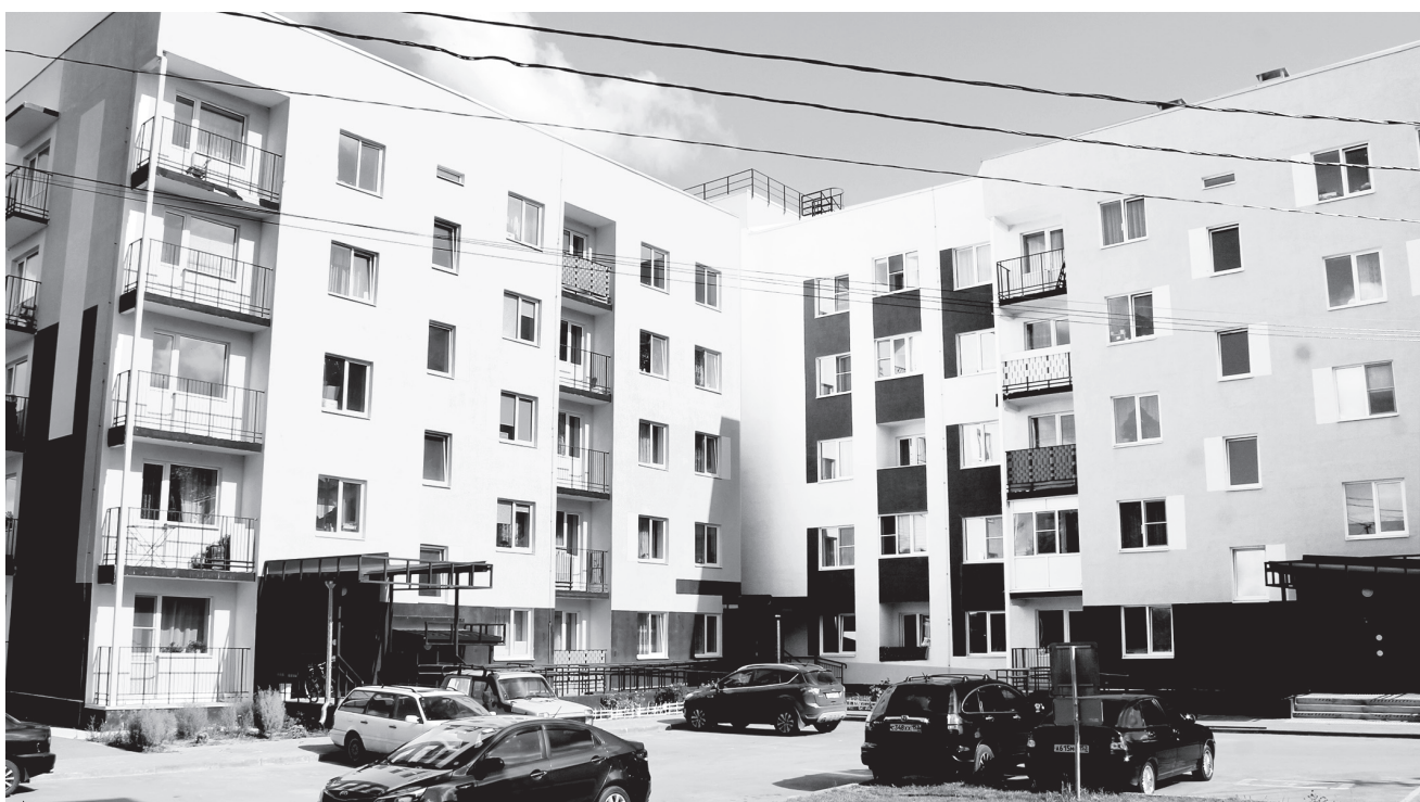
▲ В доме №40 на улице Пушкина тепловой пункт установили во время строительства
