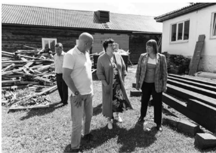
Председатель ВС РХ Сергей Сокол вместе с главой района Татьяной Акользиной и директором Бондаревской школы Натальей Кузьмичевой осматривают строительную площадку
