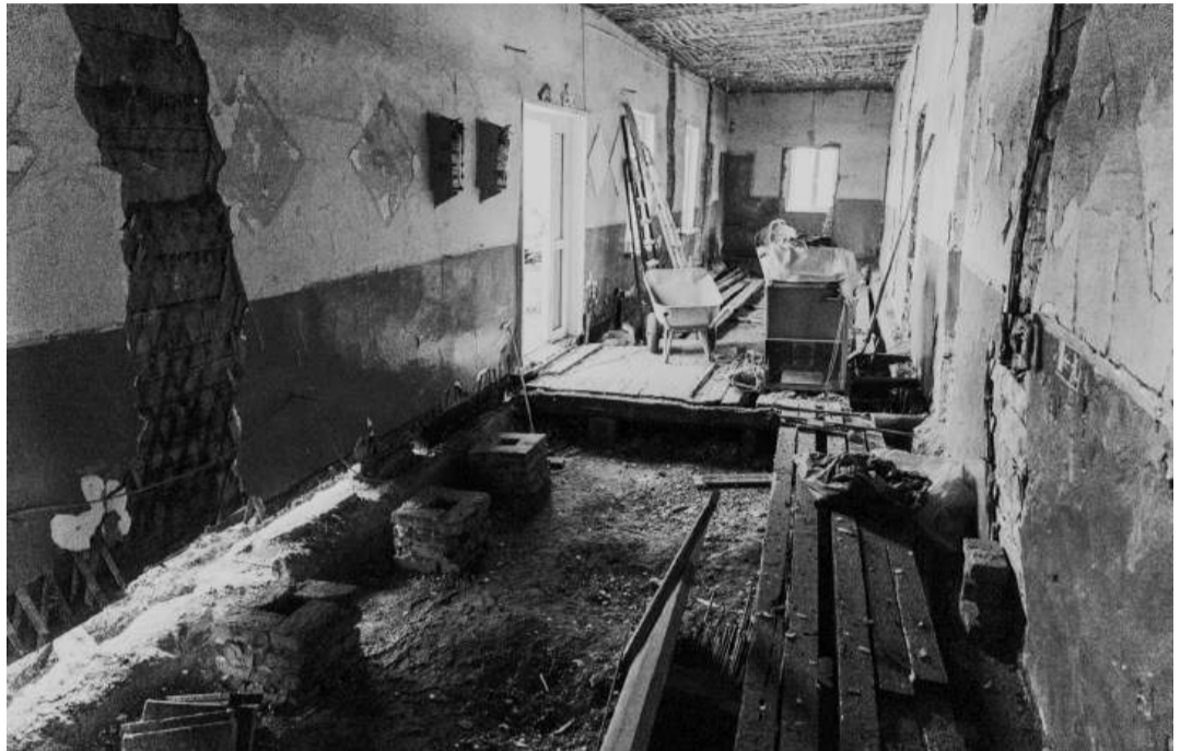
Ремонт Верх-Киндирлинской школы. Начало
