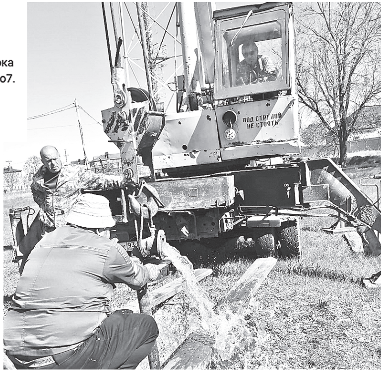
Бригада «Водоканала» на устранении аварии.
