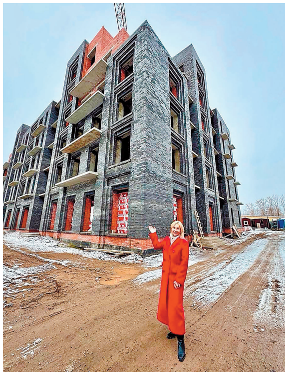
Процесс строительства нового дома в Новодвинске
