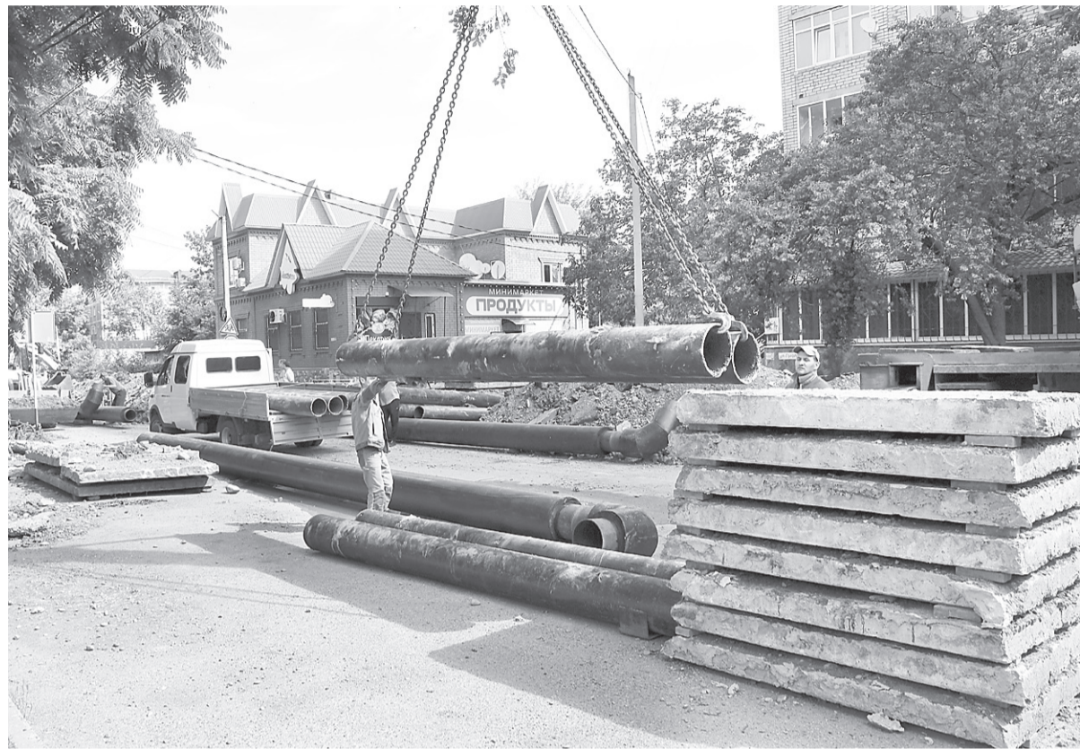
Масштабные работы развёрнуты по замене участка магистрального трубопровода на улице Луначарского
