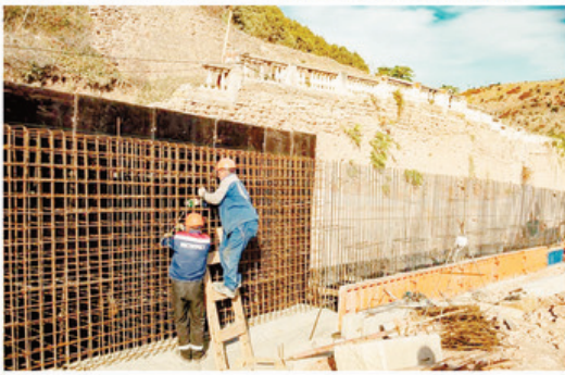
Вязка арматуры подпорной стены.
