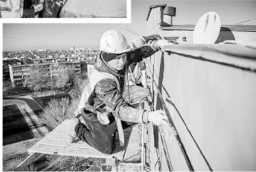
Работы на высоте требуют особой концентрации.
