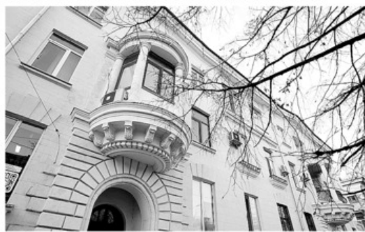
Дом №8 на улице Гоголя, над обновлением фасада которого работали полтора года.
