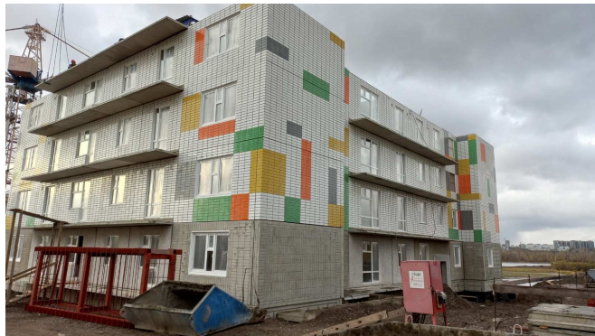
Так выглядела стройплощадка на Крайней, в районе Октябрьского моста в Ленинском районе, прошлой осенью. Теперь жильцы готовятся справлять новоселье
