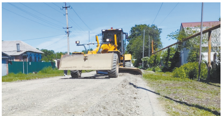
● В Мостовском поселении с начала года прогрейдировано почти 50 км дорог.
